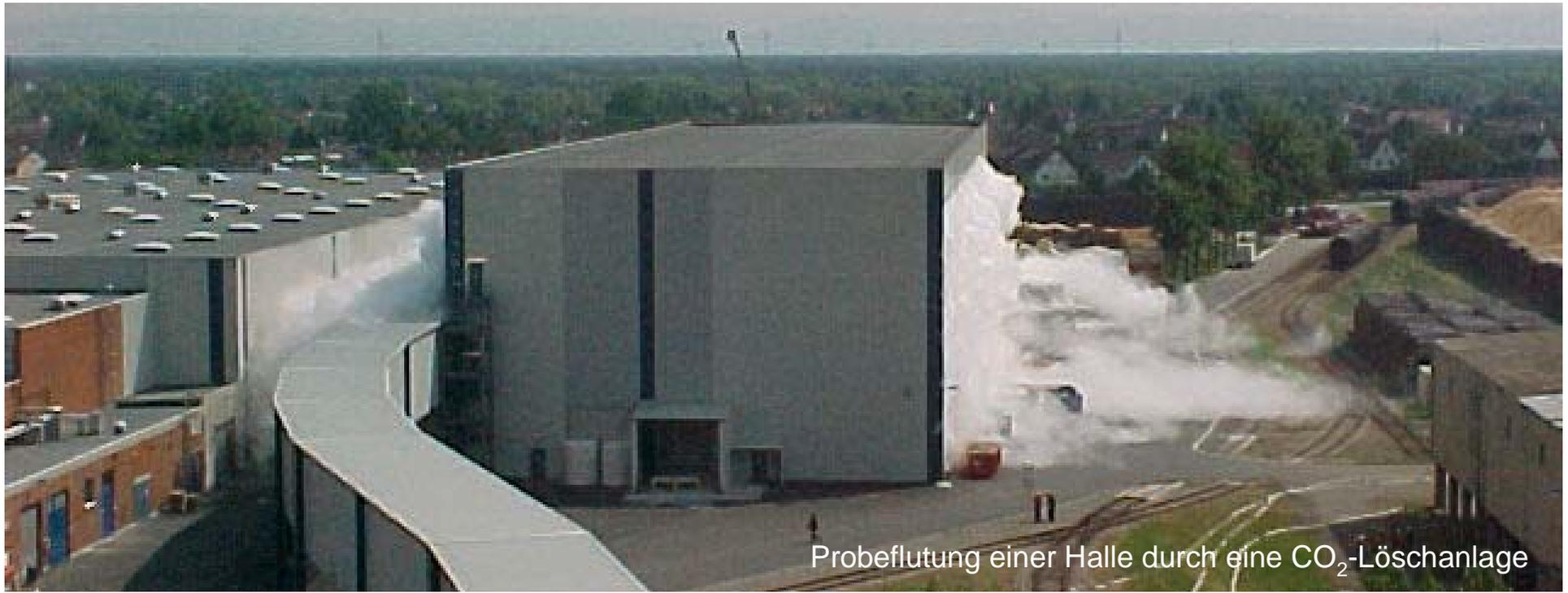
Probeflutung einer Halle durch eine CO<sub>2</sub>-Löschanlage
