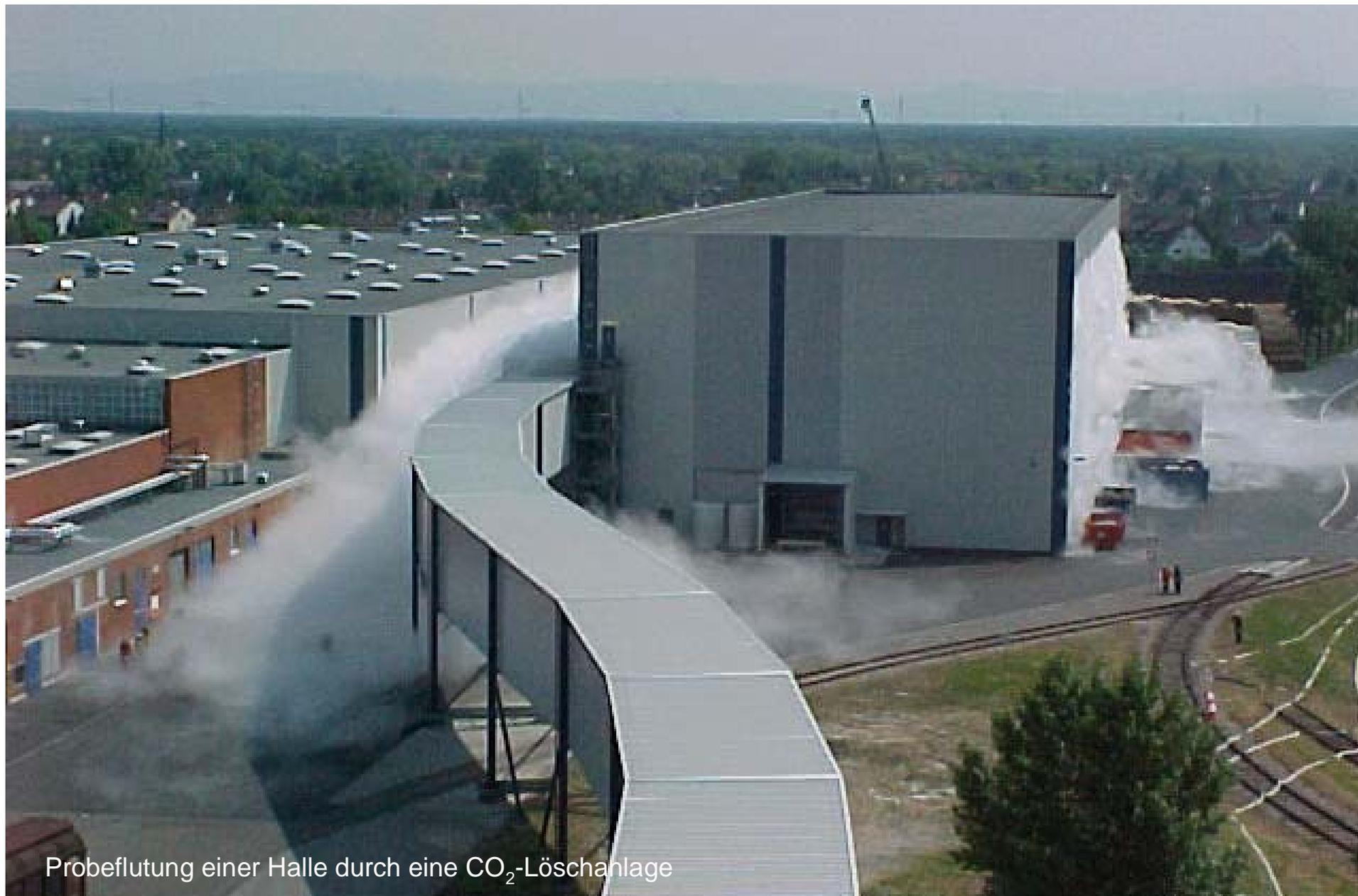
Probeflutung einer Halle durch eine CO<sub>2</sub>-Löschanlage
