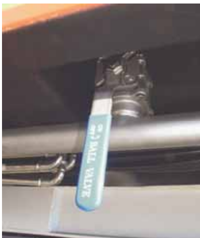
Abbildung 9a, b: Wasserablaufventil (hier: geöffnet) [Wenking, IdF NRW]
