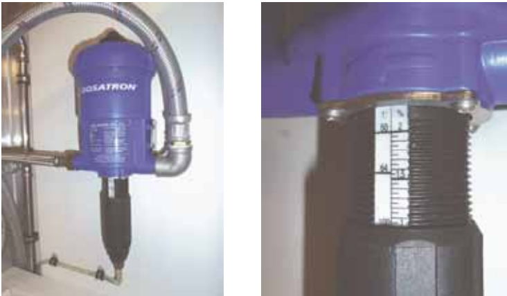
Abbildung 28a, b: Dosiereinrichtung, Zumischung 1 % (1:100) [Wenking, IdF NRW]
