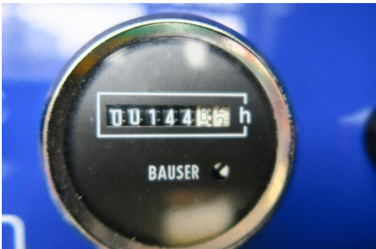
Foto 8: Betriebsstundenzähler Feuerlöschkreiselpumpe
