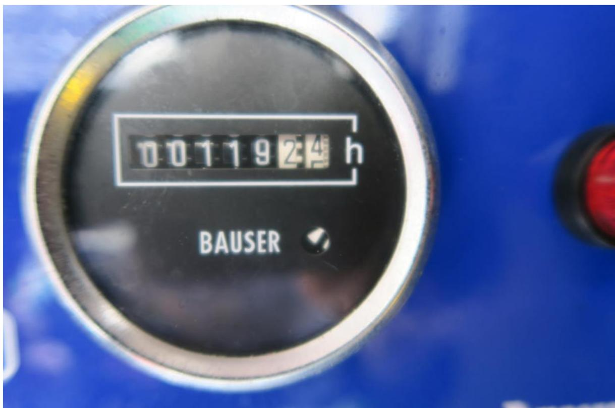
Foto 8: Betriebsstundenzähler Feuerlöschkreiselpumpe
