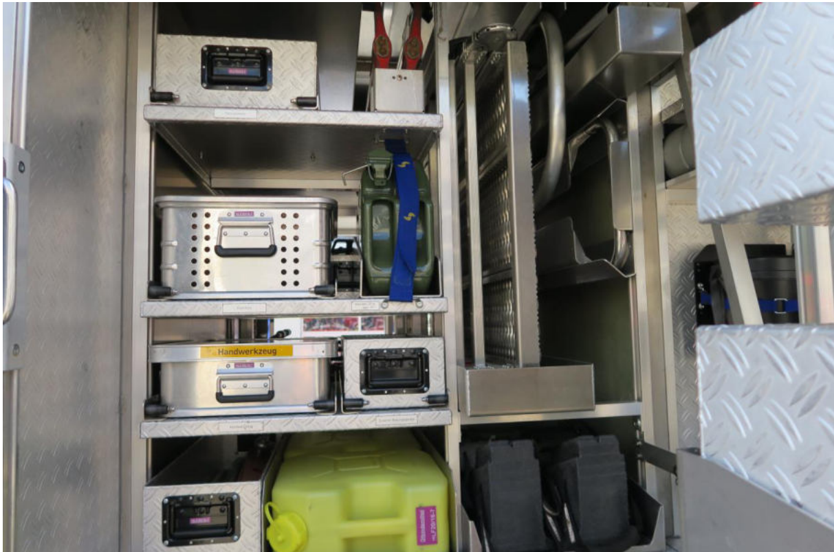
Foto 19: Ansicht Geräteraum 1 innen
