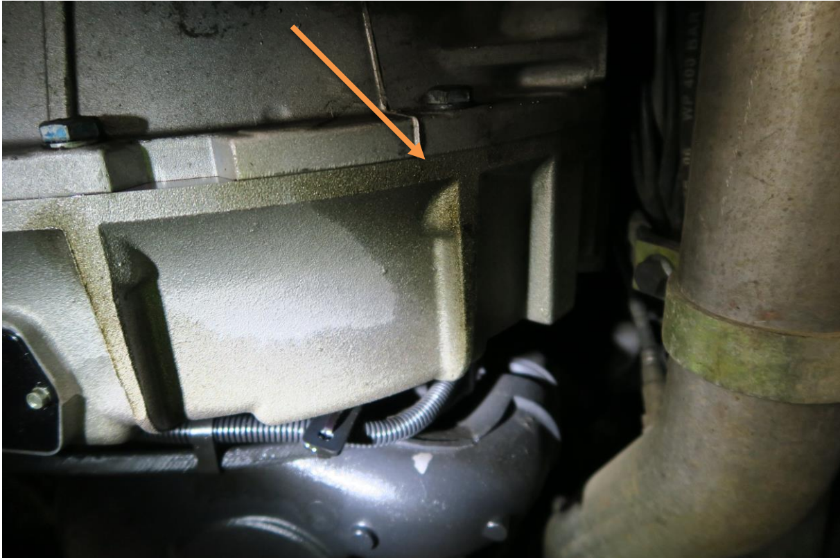
Foto 43: Motor leichter Ölverlust
