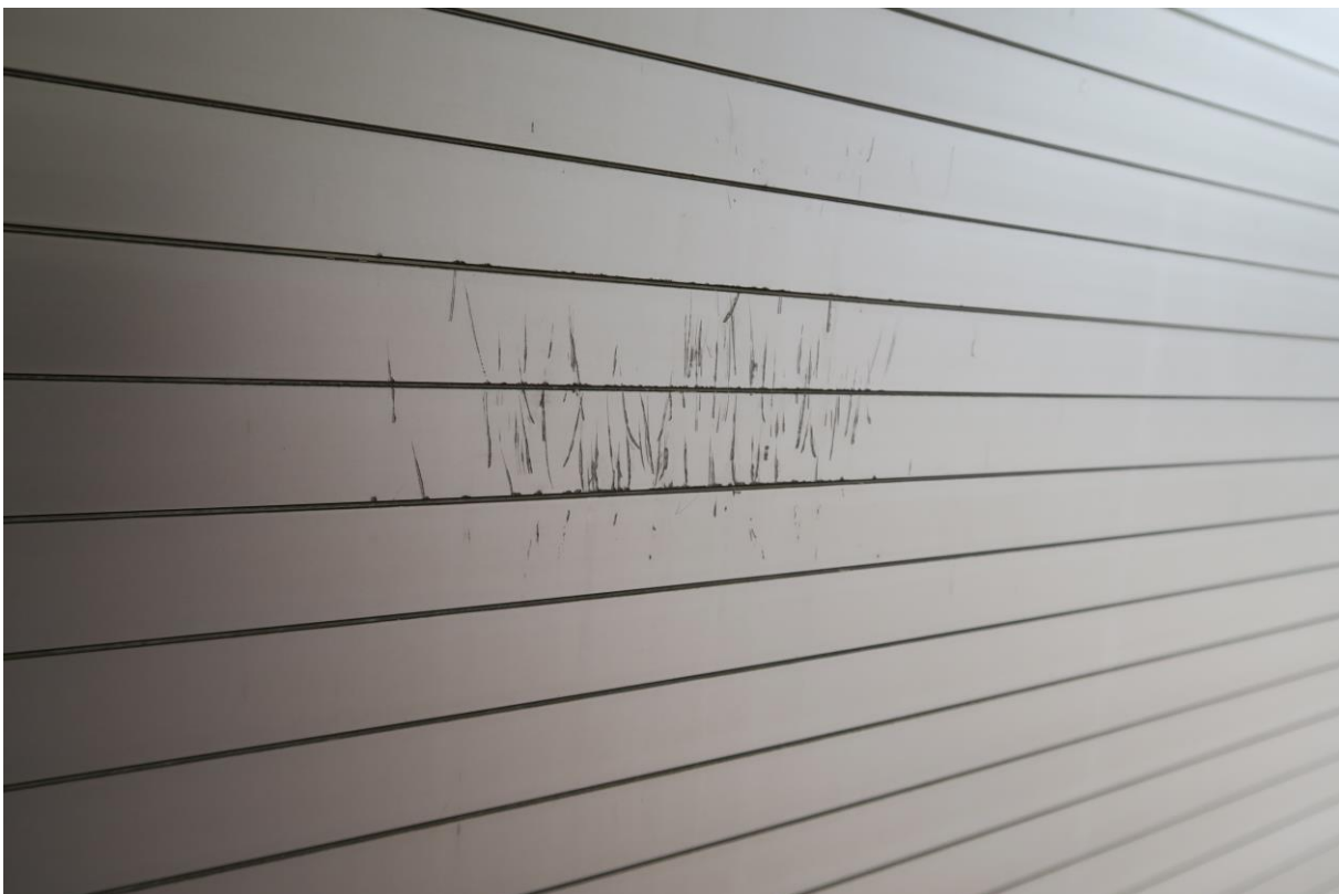
Foto 50: Lamellenverschluss G1 verkratzt
