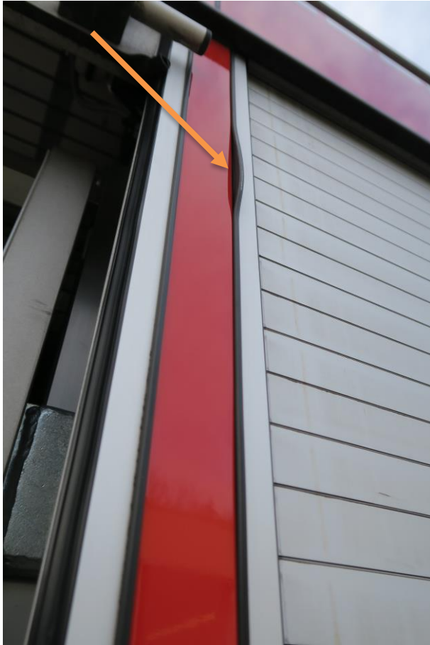
Foto 41: Dichtung Lamellenverschluss Geräteraum 3
