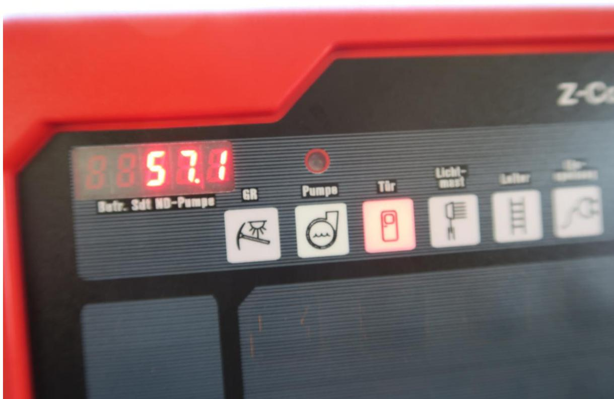
Foto 8: Betriebsstundenzähler Feuerlöschkreiselpumpe
