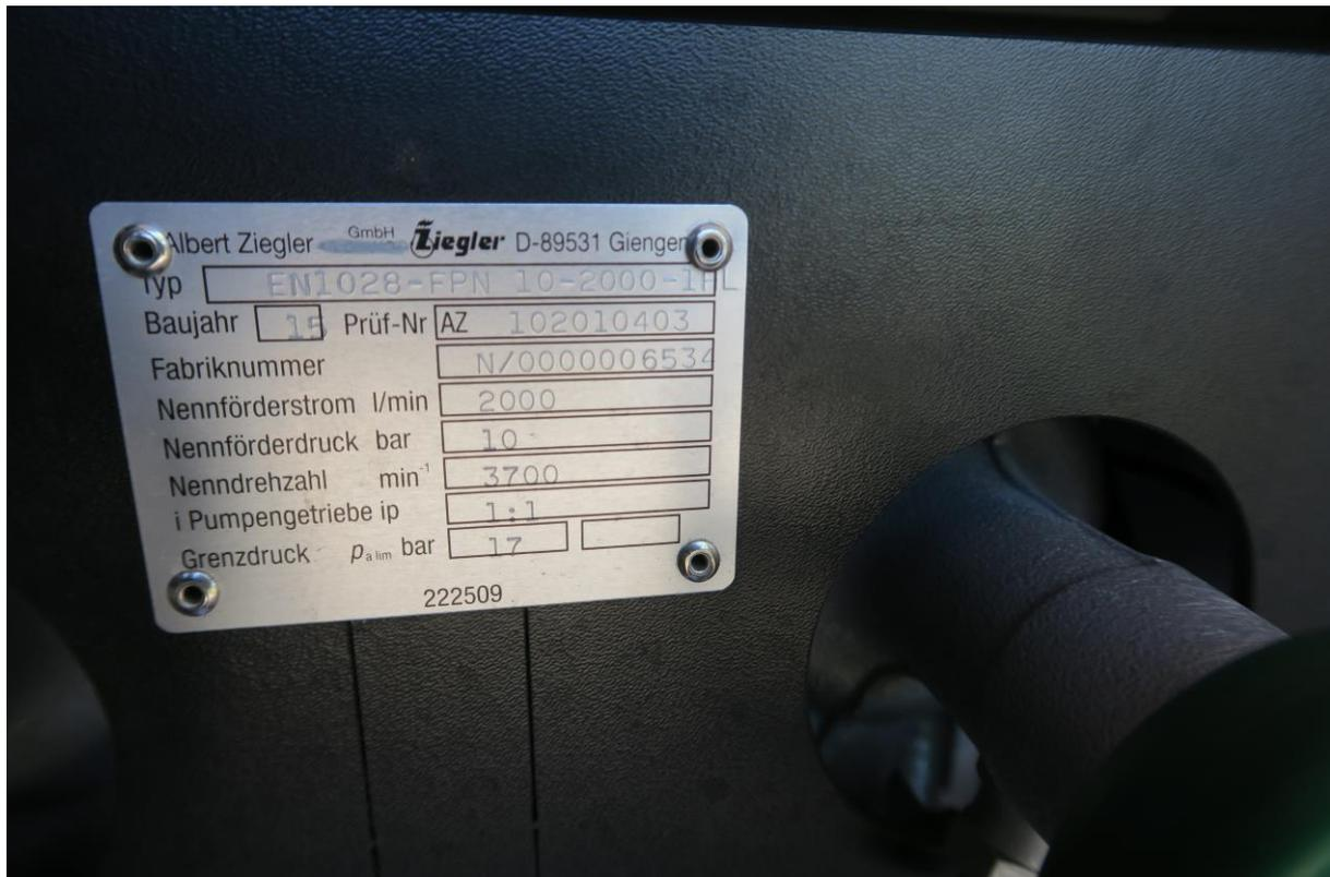
Foto 7: Typschild Feuerlöschkreiselpumpe
