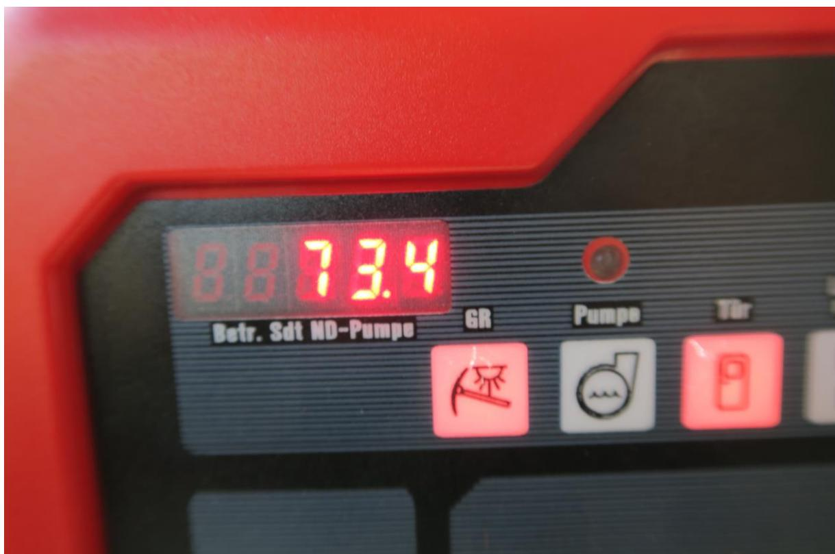
Foto 8: Betriebsstundenzähler Feuerlöschkreiselpumpe
