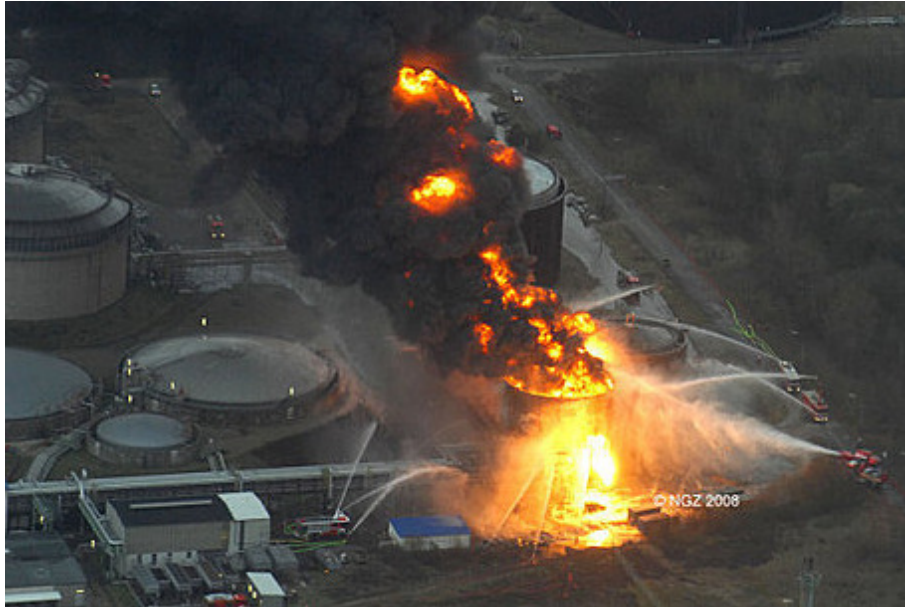
Abbildung 2: Brand eines Chemikaliertanks mit 3.000 m 3 Acrylnitril am 18.03.2008 in Köln-Worringen (Foto: Neuß-Grevenbroicher Zeitung).
