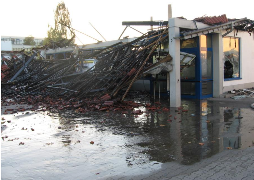
Foto: Zugangsöffnung des Angriffstrupps, Feuerwehr Krefeld
