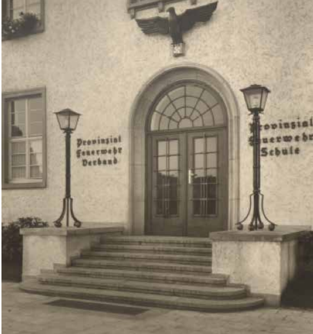
Ganz der neuen Zeit verschrieben - das Eingangsportal der Feuerweherschule am Inselbogen 1937. (© VdF-Archiv Wuppertal)
